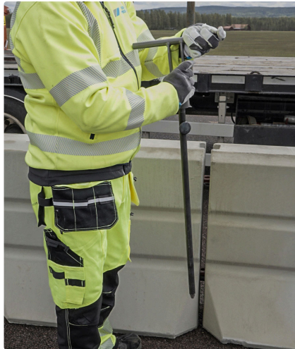
Lyft upp GP Bosse — den greppar skarvpinnen automatiskt
