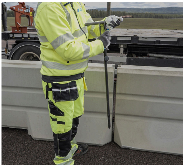
3. Skarvpinnen lyfts upp ur det monteringsfärdiga elementet. Elementet lyfts till rätt läge.
