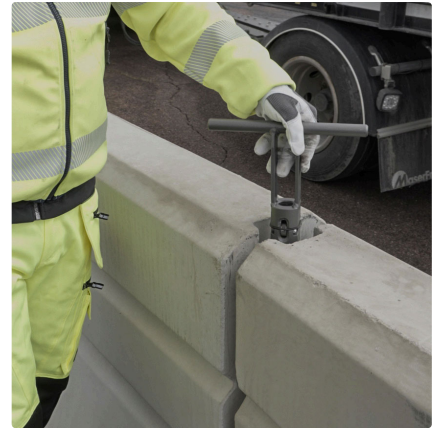
Sänk ner och "knacka" till när pinnen når sitt ändläge
