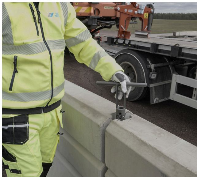
4. Skarvpinnen placeras lodrätt genom alla fyra tungor.
