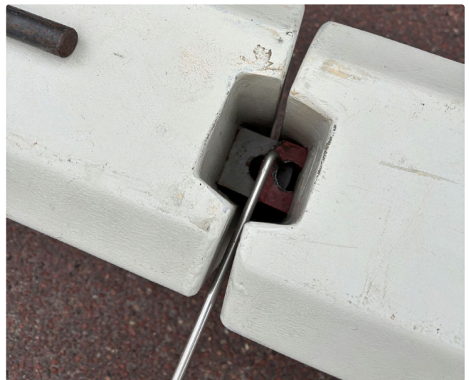
Justering av skarvjärn
